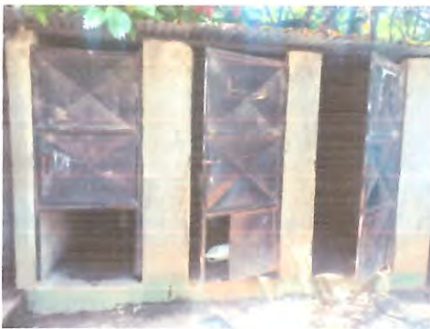
Foto 3: Sustrucción de puertas metálicas para sanitarios.
