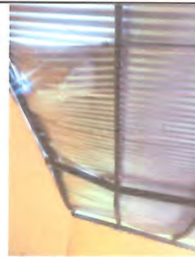
Foto 2: Sustrucción de estructura metálica para soporte de cubierta de lámina incluyendo perfiles para vigas, travesaños, sujeta con tornillería; corte, soldadura y anclaje de la estructura portante.
