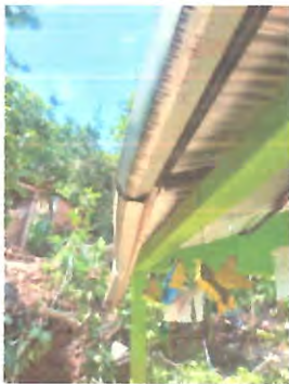
Foto 5: Sustrucción de canales para evacuación de aguas pluviales, anclaje: canal sostenido por pescantes metalicos, incluyendo sus respectivas bajadas.
