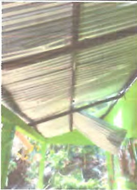
Foto 1: Sustrucción de cubierta de techo con lámina galvanizada, Tipo de lamina: troquelada Calibre: 26, incluye: fijaciones y sellado en traslapes, en área de aulas y corredor.
